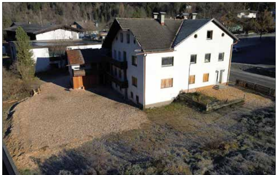
Es ist beabsichtigt, das „Staudner-Haus“ abzureißen und eine schöne Wohnanlage zu errichten (Bauherr: Osttiroler Gemeinnützige Wohnungs- und Siedlungsgenossenschaft - OSG)
