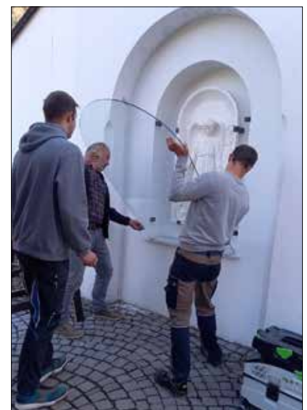
Meister Gollner mit Gehilfen beim Einsetzen der Verglasung
