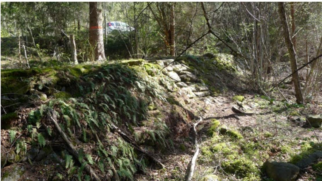
Die „Kircher-Mauer“, ein trocken gemauerter Schutzdamm, errichtet nach den Vermurungen der Jahre 1881/82.
