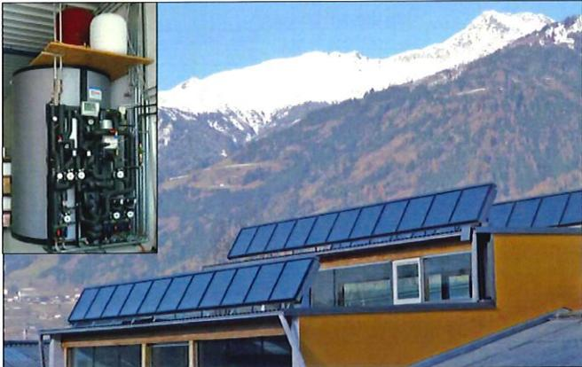
Kombination einer alten Holzheizung mit **Solaranlage und 5000 Liter Buso-Pufferspeicher** bei einem Gewerbebetrieb in der Peggetz. Zum Großteil wird die Werkstatt **mit Solarenergie beheizt**.
