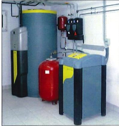
Sanierung eines Wohnhauses in Ainet mit kompletter Erneuerung der Sanitäreinrichtungen. Die Installation der **Heizung mit Erdwärmepumpe** ermöglicht künftig ein **kostengünstiges und sauberes Heizen**.
