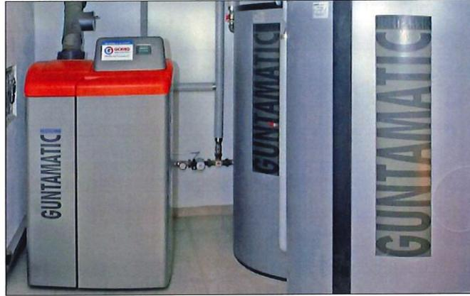
Umbau einer Ölheizung kombiniert mit einem **Holzvergaser und 3500 Liter Pufferspeicher** als Heizung für zwei Einfamilienhäuser und eine Werkstatt.
